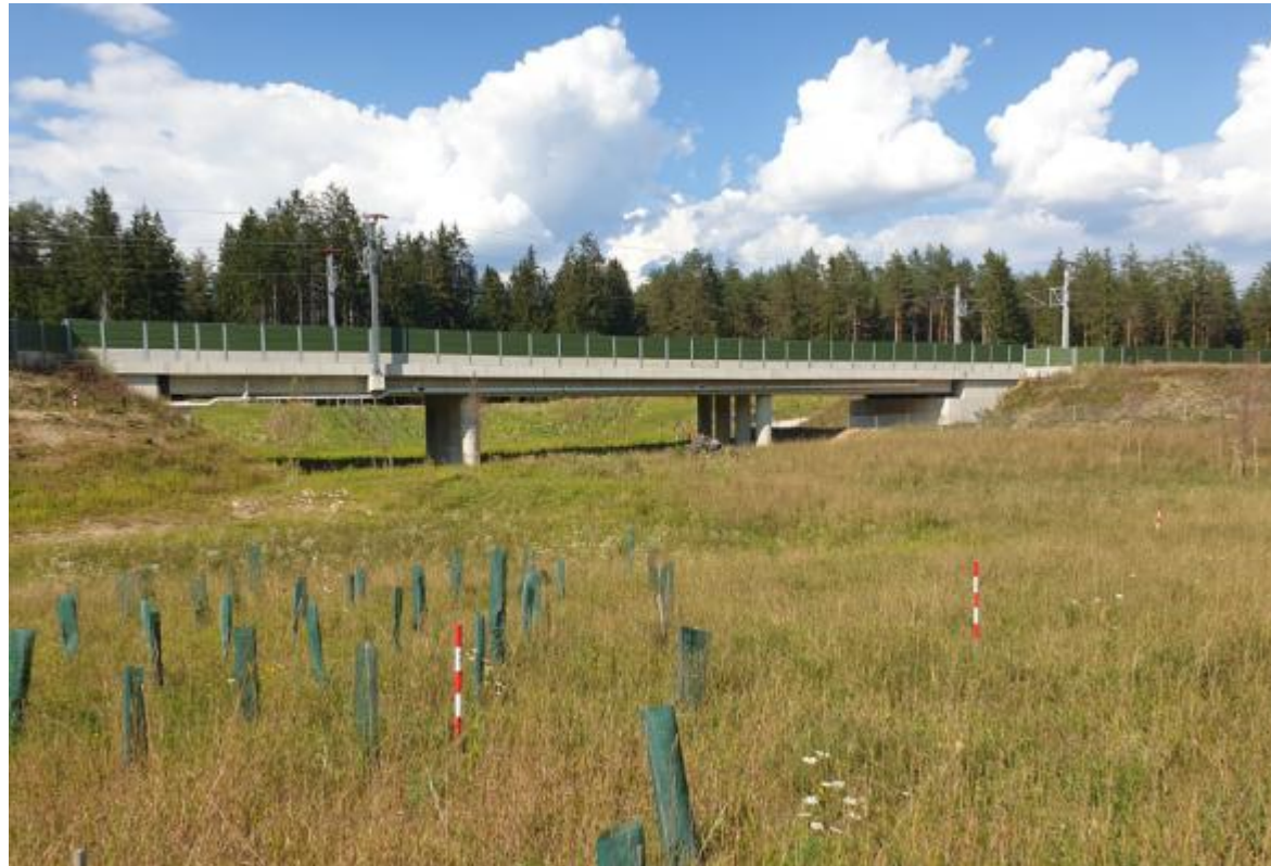
Begehung am 16.08.2022 – Unterführung an der Koralmbahn
