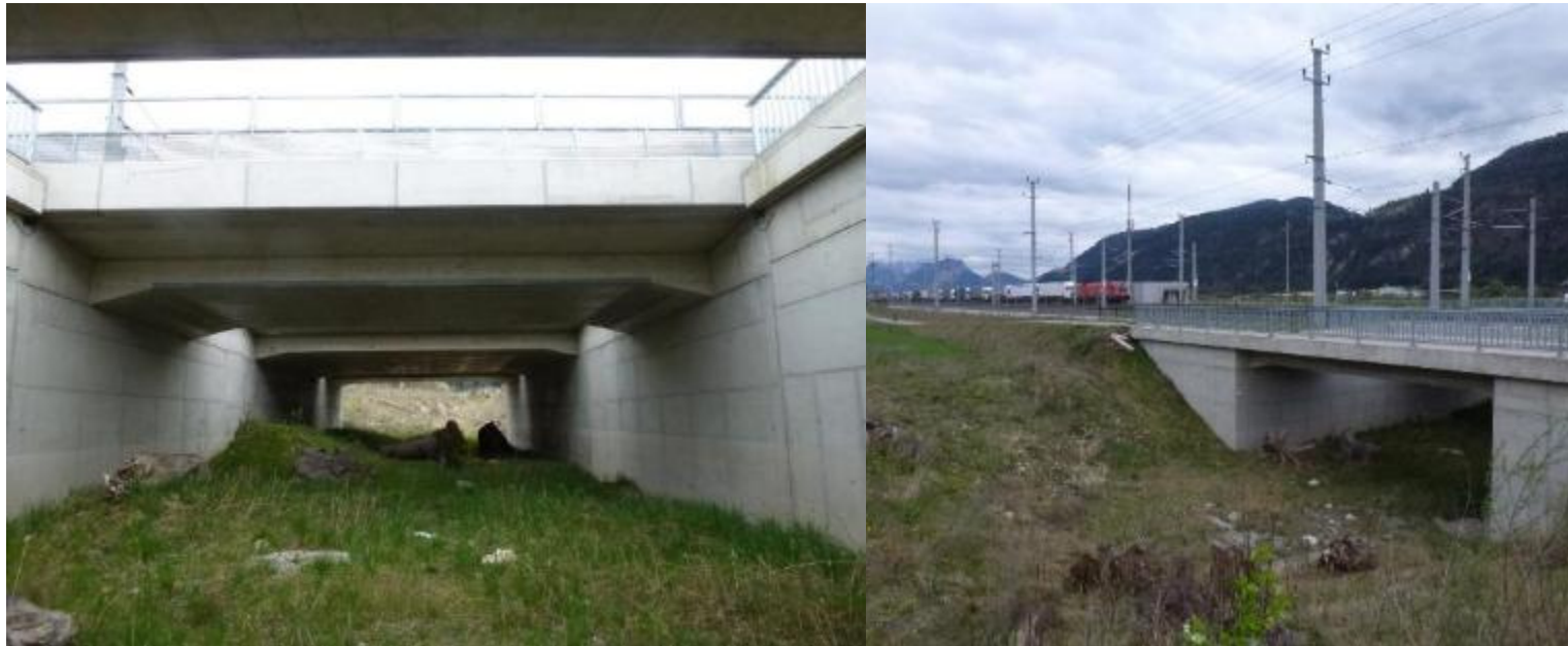
Querungshilfen bei Neubauprojekten, Unterquerung beim Maukenbach in Radfeld
