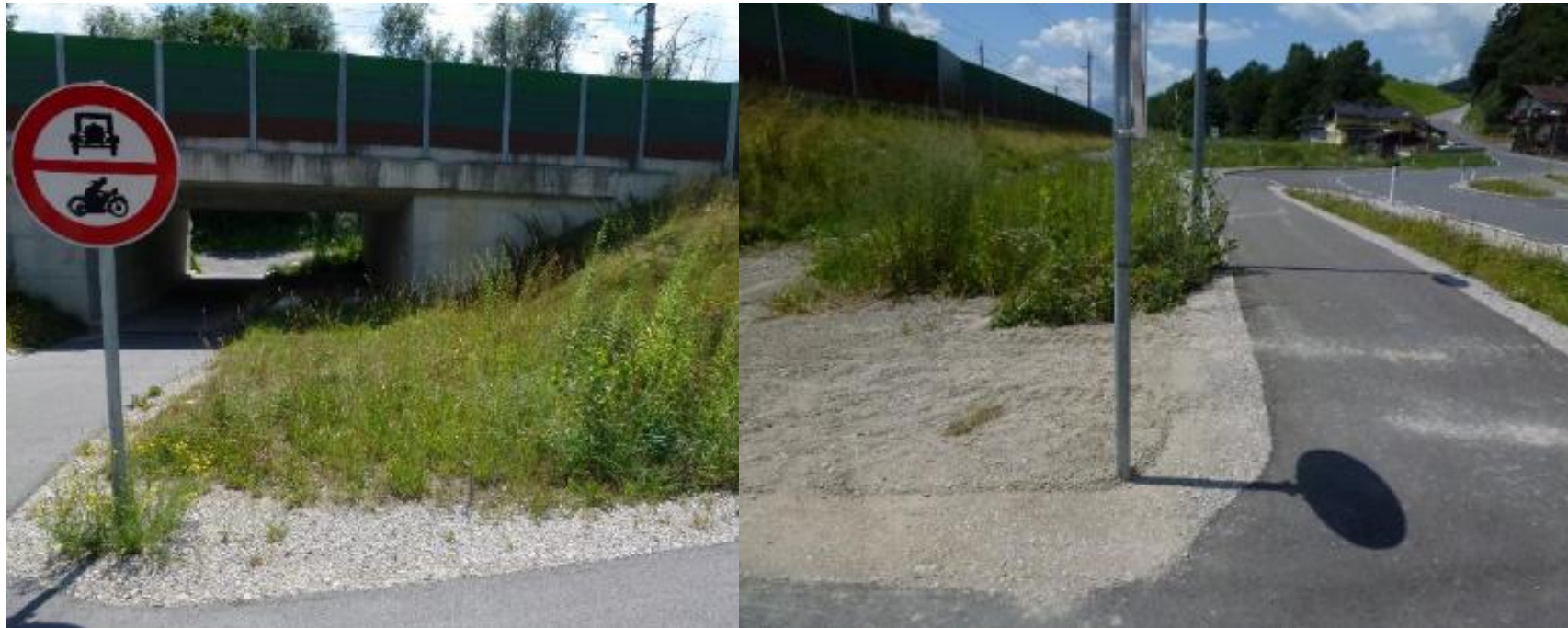
Querungshilfen bei Neubauprojekten, Unterquerung bei Baumkirchen/Tirol
