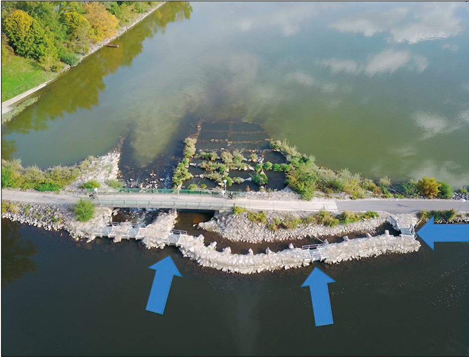
Abb. 7: Der Altarm Altenwörth wird seit Errichtung des gleichnamigen Donaukraftwerks (1986) über eine Traverse rückgestaut. Im Rahmen des Projekts LIFE Network Danube Plus wurde die bestehende Fischwanderhilfe (Beckenpass) verlängert und mit drei Einlaufbauwerken (blaue Pfeile) versehen. Je nachdem welches der drei Bauwerke geöffnet ist, stellt sich im Altarm flussauf der Traverse (Bildvordergrund) ein hoher, mittlerer oder niedriger Wasserstand ein. Die so erzielten jahreszeitlichen Wasserstandsschwankungen betragen im Altwasser ca. 0,5 m und erzeugen großflächige wechselfeuchte Zonen auf den neugeschaffenen Flachufeln (siehe Abbildung 2). – Fig. 7: Since the construction of the Danube power plant Altenwörth (1986), the oxbow lake Altenwörth has been impounded via a traverse. Within the framework of the LIFE Network Danube Plus project, the existing fish migration facility was extended and was provided with three inlet structures (blue arrows). Depending on which of the three structures is open, the water level in the oxbow lake upstream of the traverse (foreground) is high, medium or low. The achieved seasonal water level fluctuations amount to approx. 0.5 m in the oxbow lake and create large alternating wet zones on the newly created shallow banks (see Figure 2).
