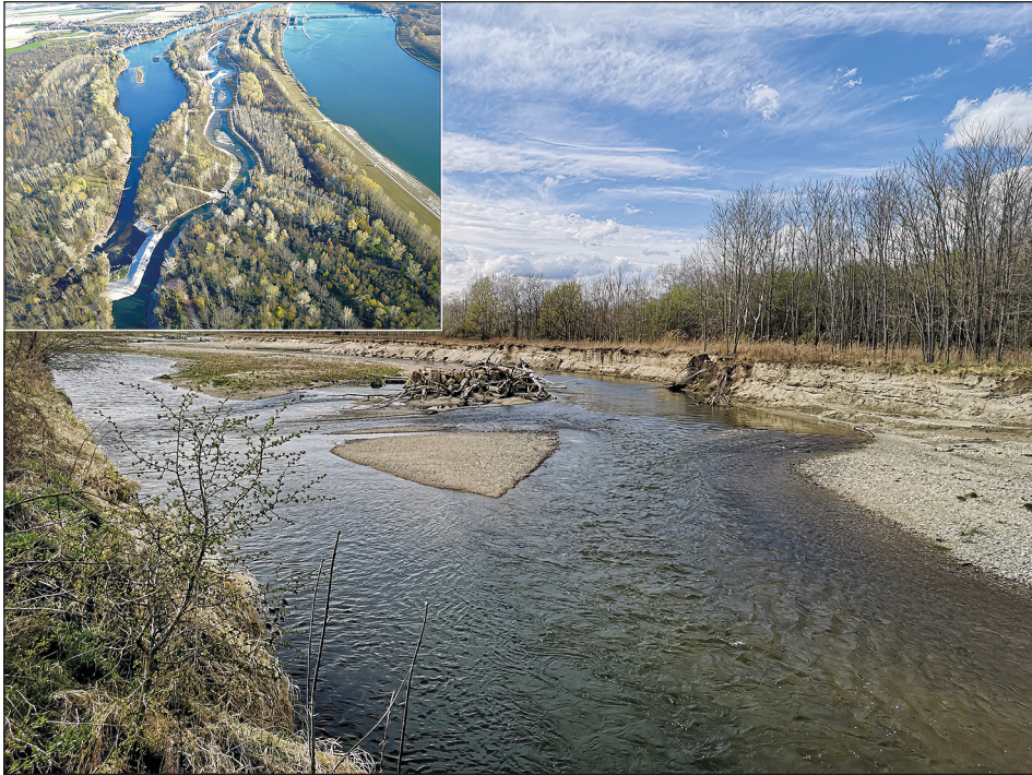
Abb. 5: Umgehungsarm beim Donaukraftwerk Altenwörth; kleines Bild: unterster Abschnitt zwischen Altarm und Kraftwerk in Form eines neu geschaffenen 3 km langen Nebenarms; großes Bild: strukturierter Abschnitt im Bereich des weiter flussauf liegenden Umleitungsgerinnes der Zubringer Kamp und Krens (LIFE Network Danube Plus). – Fig. 5: Bypass arm at the Danube power plant Altenwörth; small picture: lowest section between the old Danube and the power plant in the form of a newly created 3 km long side channel; large picture: restored section in the area of the diversion channel of the tributaries Kamp and Krens further upstream (LIFE Network Danube Plus).
